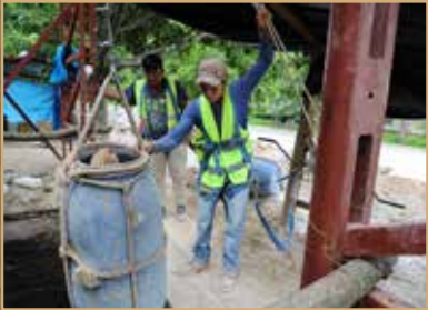
Se trabaja en la extracción de material en los pozos de visita.
