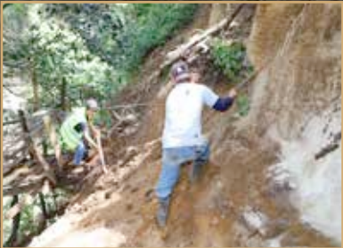
La obra concluirá en mayo de 2021, en la misma trabajan 50 personas.
