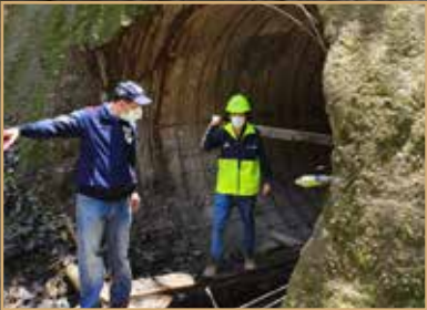
El Rector, Ing. Murphy Paiz, supervisa el avance de la obra.
