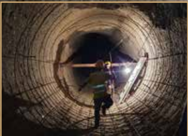
El colector es elaborado con armadura de refuerzo de 2.75 metros de diámetro fundido con concreto de 1,102 metros lineales.
