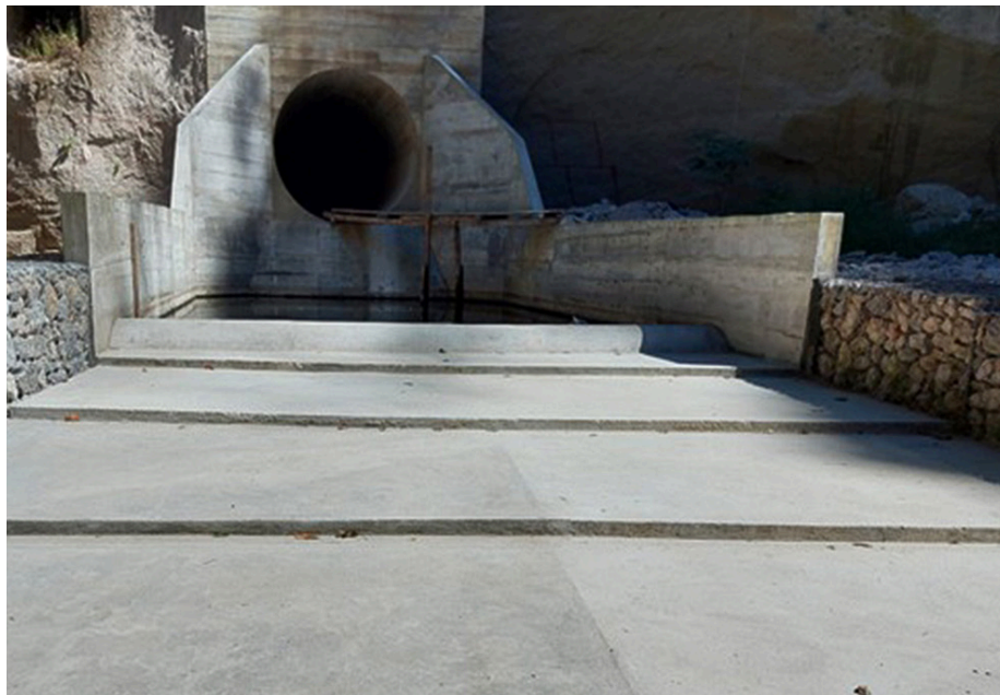
Las aguas pluviales y residuales ingresan en el nuevo colector, lo cual beneficia a terrenos universitarios y aledaños.
