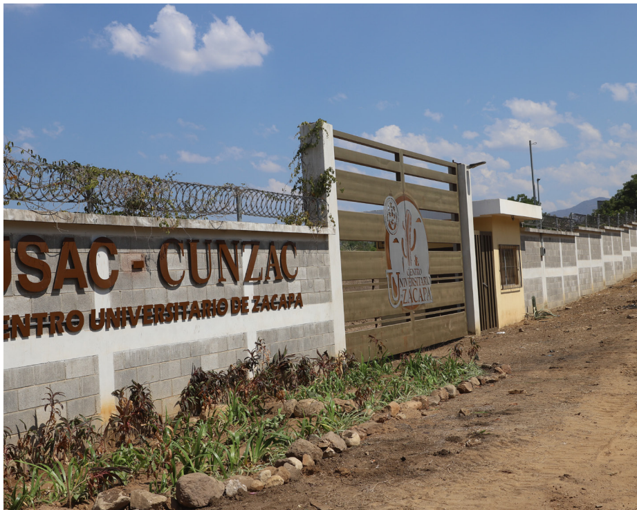
El muro que rodea el centro universitario tiene una extensión de 1358 metros lineales.
